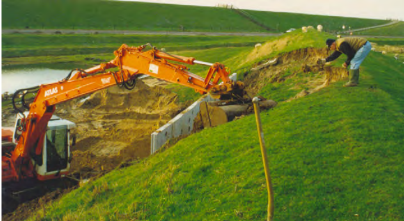
Aanvullen van grond achter de tweede muur (Foto: Giel Witte)
